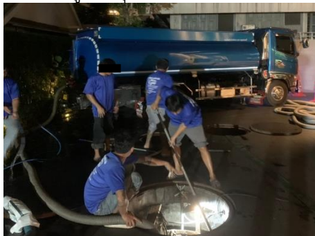
ทำความสะอาดบ่อเกรอะและสูบล้างตะกอนไขมันส่วนเกินระบบบำบัด
