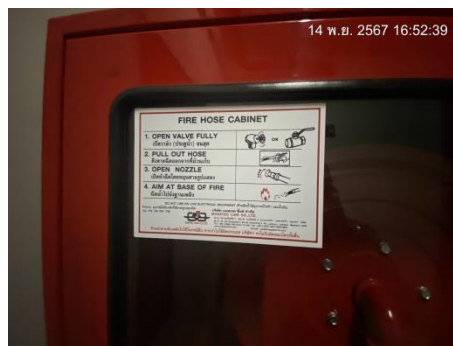
ตู้เก็บสายฉีดน้ำดับเพลิงพร้อมอุปกรณ์ (FHC) และป้ายแสดงวิธีการใช้อุปกรณ์
