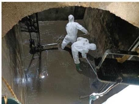
ทำความสะอาดบ่อเกรอะและสูบล้างตะกอนไขมันส่วนเกินระบบบำบัด
