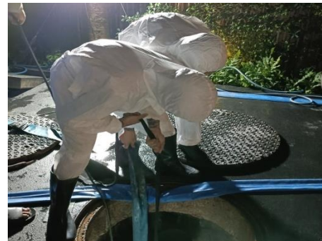
ทำความสะอาดบ่อเกรอะและสูบล้างตะกอนไขมันส่วนเกินระบบบำบัด
